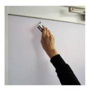
STEP:11 水と空気抜きです。真ん中から外側へと 抜いていきます。ある程度力を入れて スキージーでゆっくり抜いていきます。
