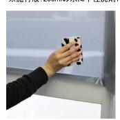
STEP:08 スキージーで空気と水分をあら抜きします。
