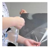
STEP:05 フィルムの粘着部分にも霧吹きで 施工液をかけます。 ※施行液:200mlの水に中性洗剤1~2滴混ぜたもの
